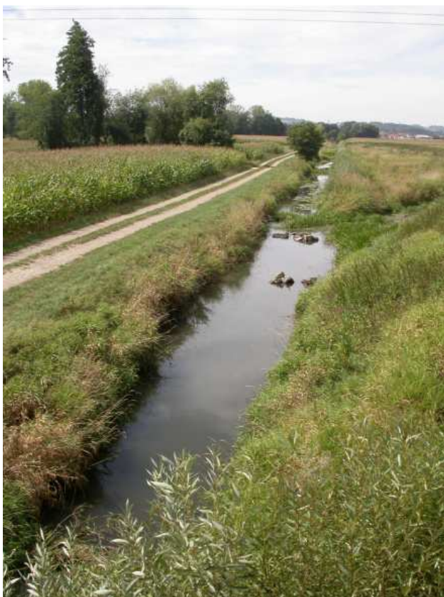
Foto 12: Leitenbach (L5), Richtung flussaufwärts, 24.8.2015.
