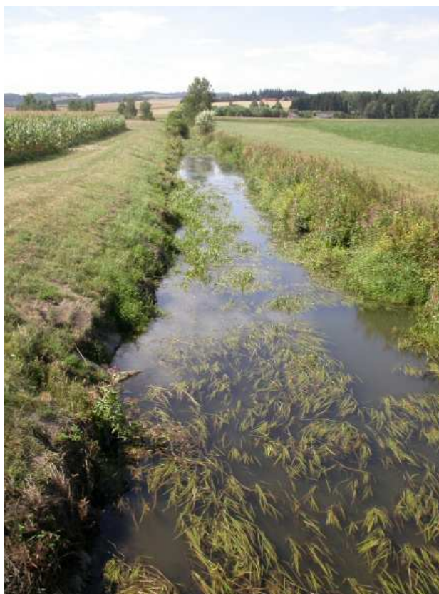
Foto 7: Leitenbach (L3), Richtung flussaufwärts, 24.8.2015.
