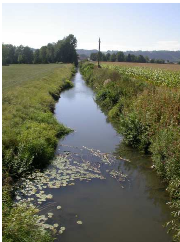
Foto 8: Leitenbach (L3), Richtung flussaufwärts, 24.8.2015.
